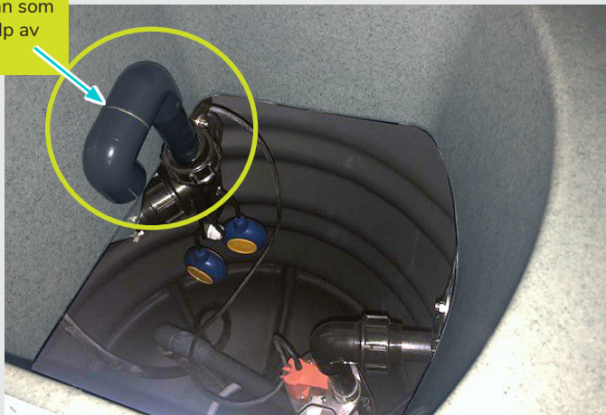
Bild 5: Montering av S-krök
