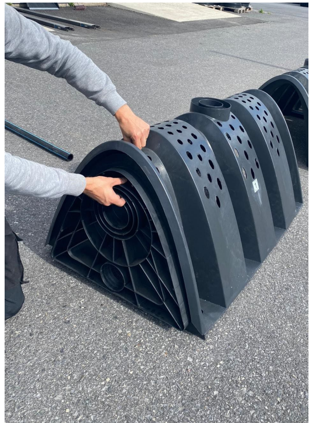
Fäst frontplattan med hålet urtaget för spridarröret i modul 1.
