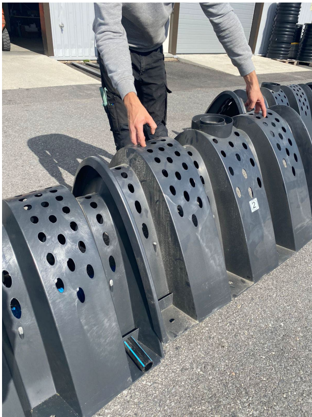
Placera ut tunnelmodulerna i ordningsföljden 1-4, med modul 1 närmast reningsverket.
