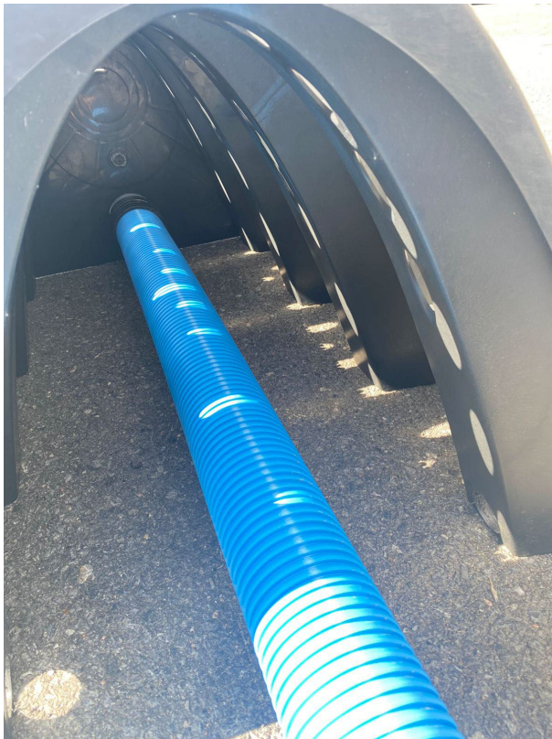
Sätt in spridarröret i tunneln och fäst det i frontplattan med hålet i modul 1. Se till att spridarhålen vänder neråt mot krossbädden.
