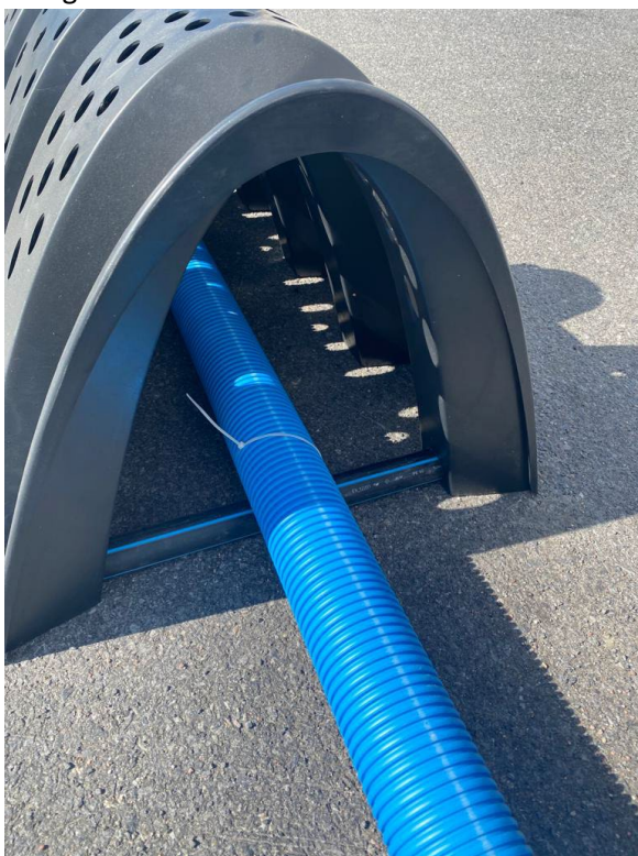
Fäst spridarröret i stöden med buntband.
