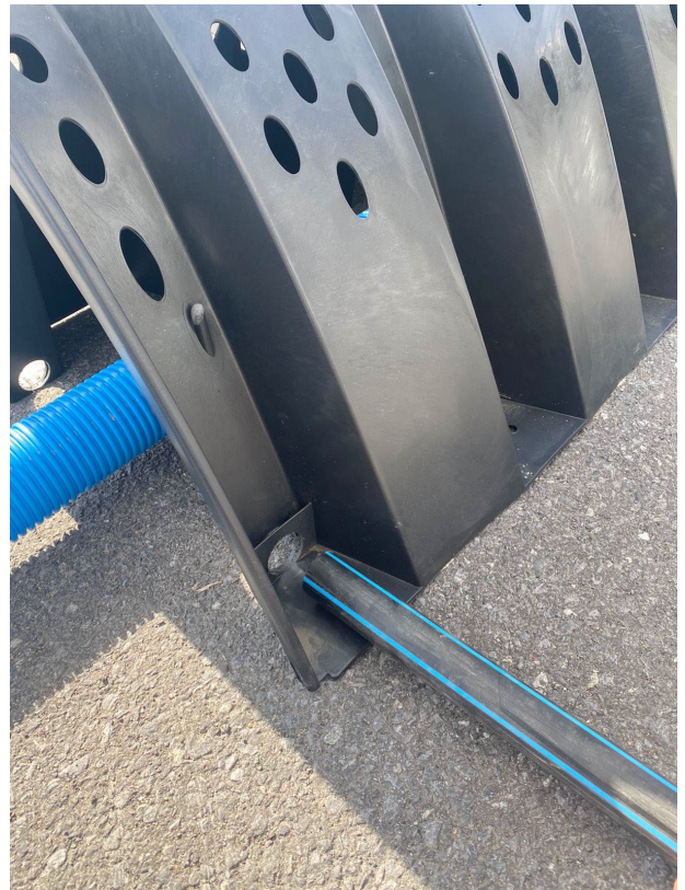
Trä in stödrören i nedre kanten av tunnelmodulerna. Dessa fungerar som stöd för spridarröret inne i tunneln.
