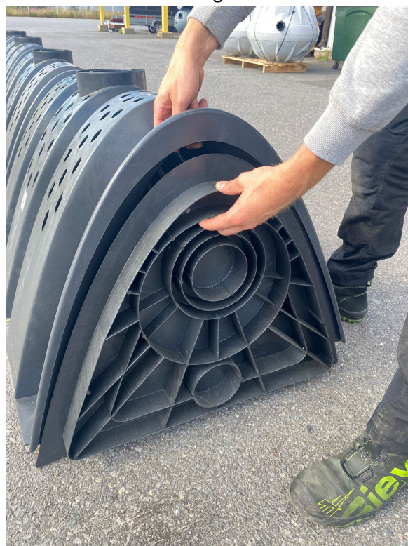
Fäst den andra frontplattan i sista tunnelmodulen, nr 4.
