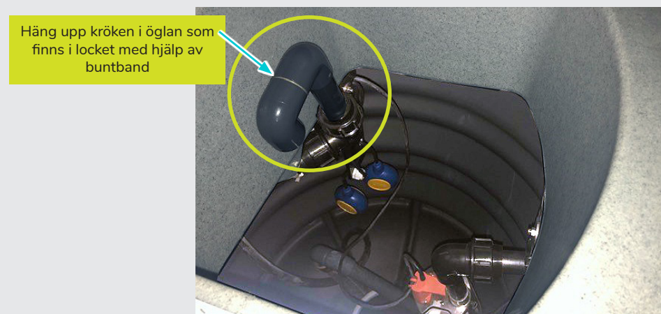
Bild 7: Montering av S-krök
